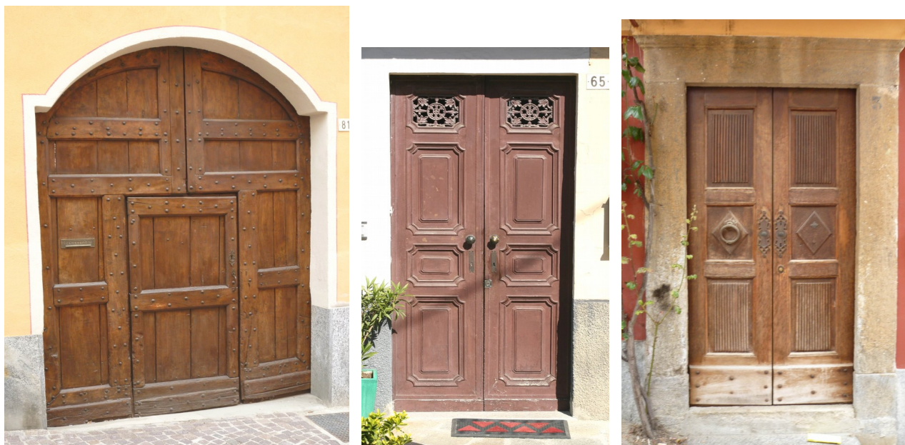
Esempi positivi di porte e portoni originari da conservare ed eventualmente riproporre.
